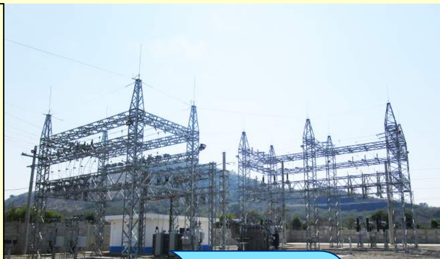
Subestación Quesada 69/13.8 kV
