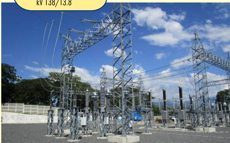
Subestación Guanagazapa kV 138/13.8
